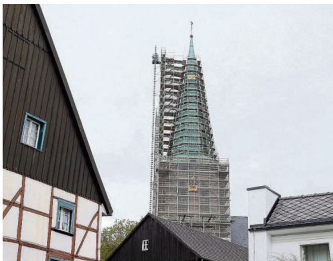
Über Monate hinweg bestimmte das Bild der eingerüsteten Stadtkirche den Blick auf die Unnaer Innenstadt. Mittlerweile ist der Turm restauriert und erstrahlt ab der kommenden Woche abends blau.
