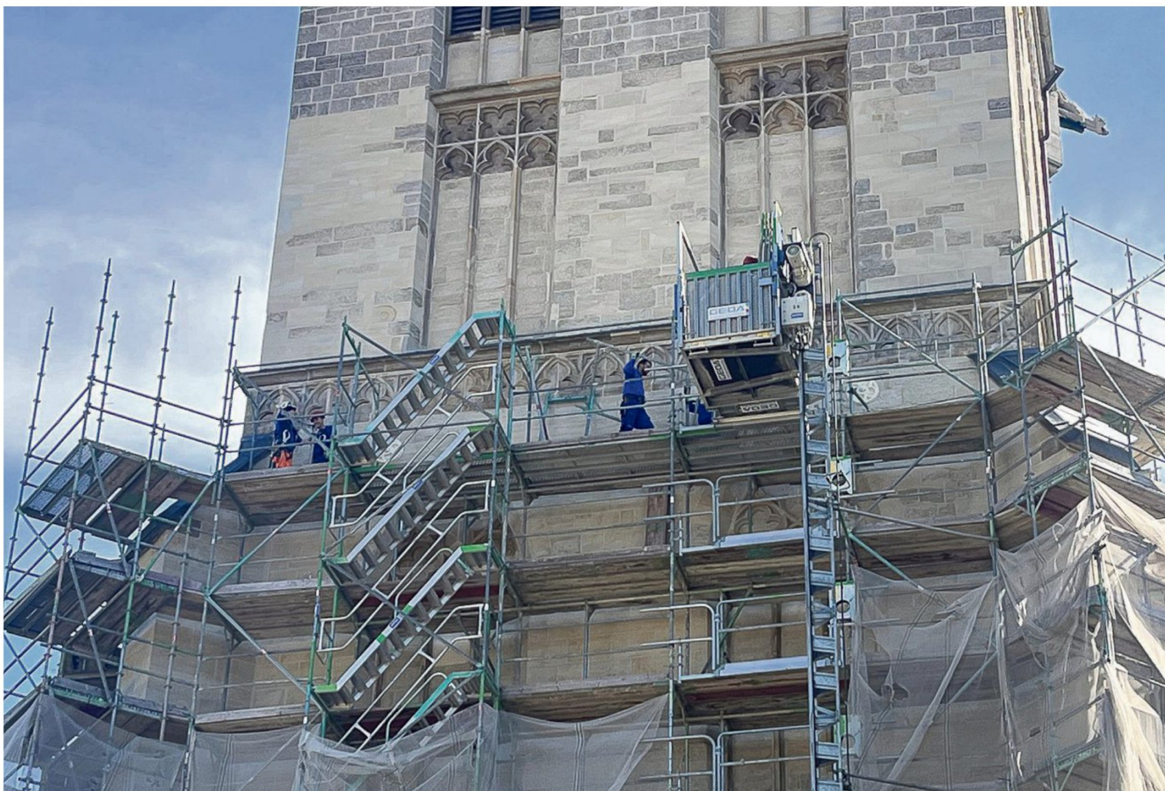
Nach vier Jahren wird das Gerüst an der Stadtkirche in Unna abgebaut.
