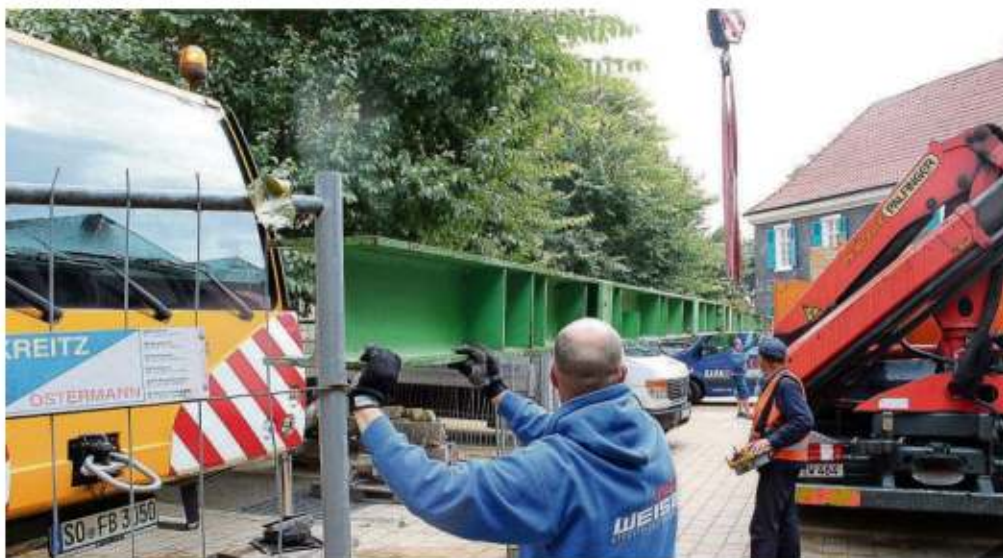
Erst am Boden werden die Ausmaße des Stahlträgers deutlich. Er misst 18 Meter und besteht aus drei Einzelteilen.
