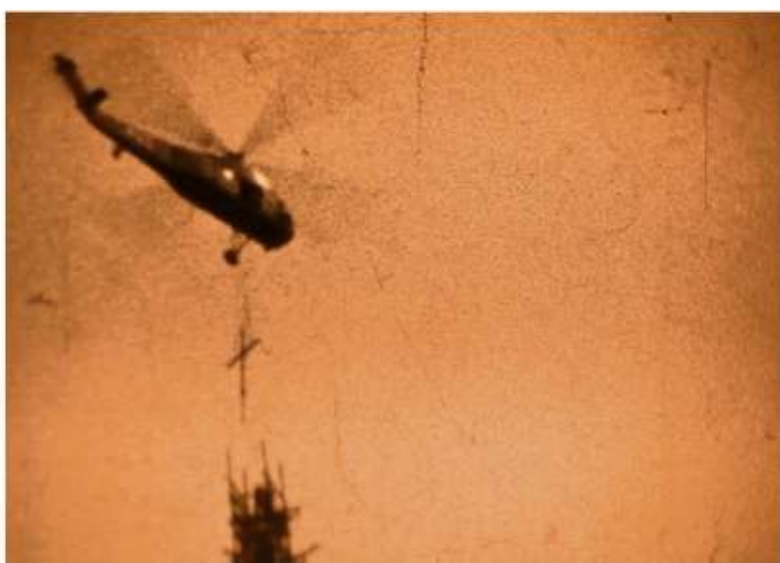
Der entscheidende Moment am 13. April 1959, festgehalten von der Doppel-8-Kamera Margot Nowodworskis: Zwei Handwerker bekommen die Fangleine des Kreuzes zu fassen, das ein Sikorsky-Hubschrauber der damals noch jungen Bundeswehr auf den Kirchturm getragen hat.
