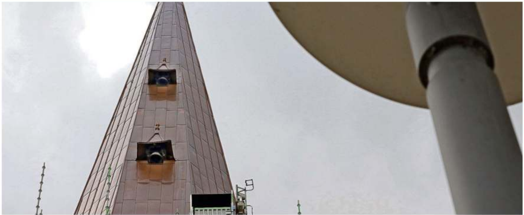
Die zwei Hauben, die aus dem westlichen Turmdach herausragen, sind die Dächer der Stundenglocken – Bestandteile des Kirchturms seit eh und je.
