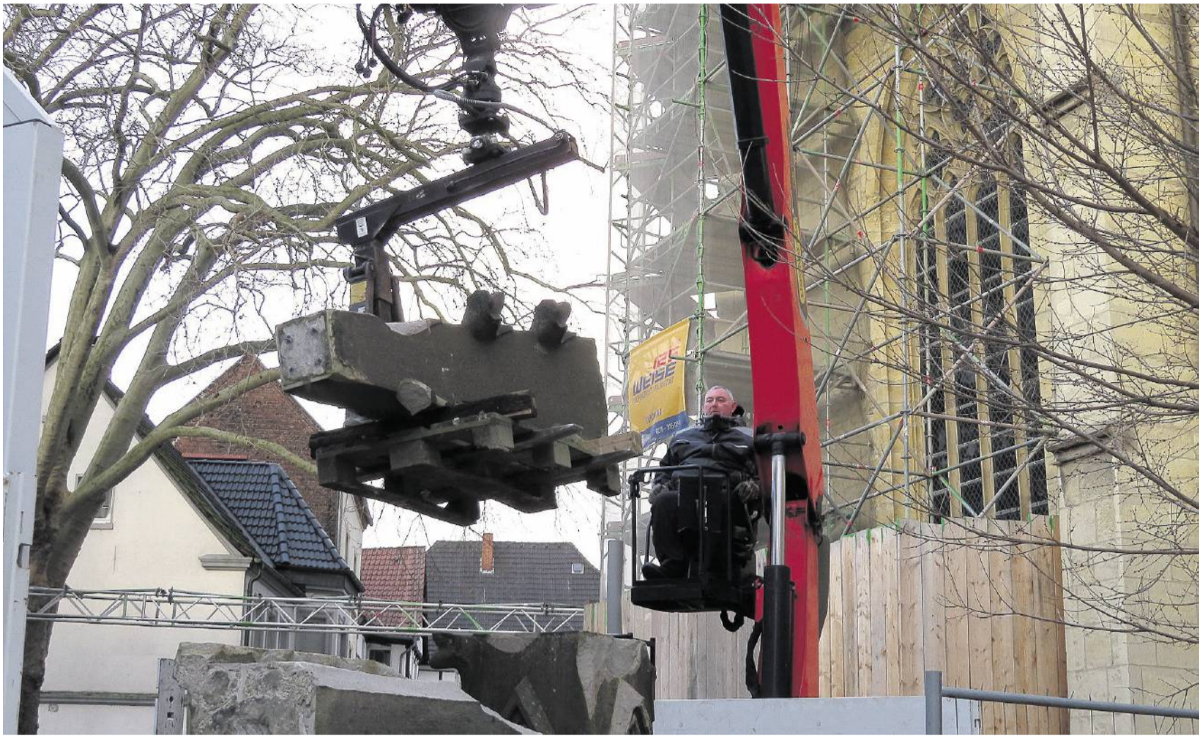
Die im Sturm Friederike Anfang 2018 herabgestürzte Fiale der Stadtkirche ist wieder in Unna gelandet, nachdem sie in der Werkstatt eines Steinmetzes für die Rekonstruktion vermessen worden war. Die Trümmer der Original-Eckspitze sollen in Unna in irgendeiner Weise erlebbar gemacht werden. Wie, darüber wird noch beraten. FOTO SMULKA
