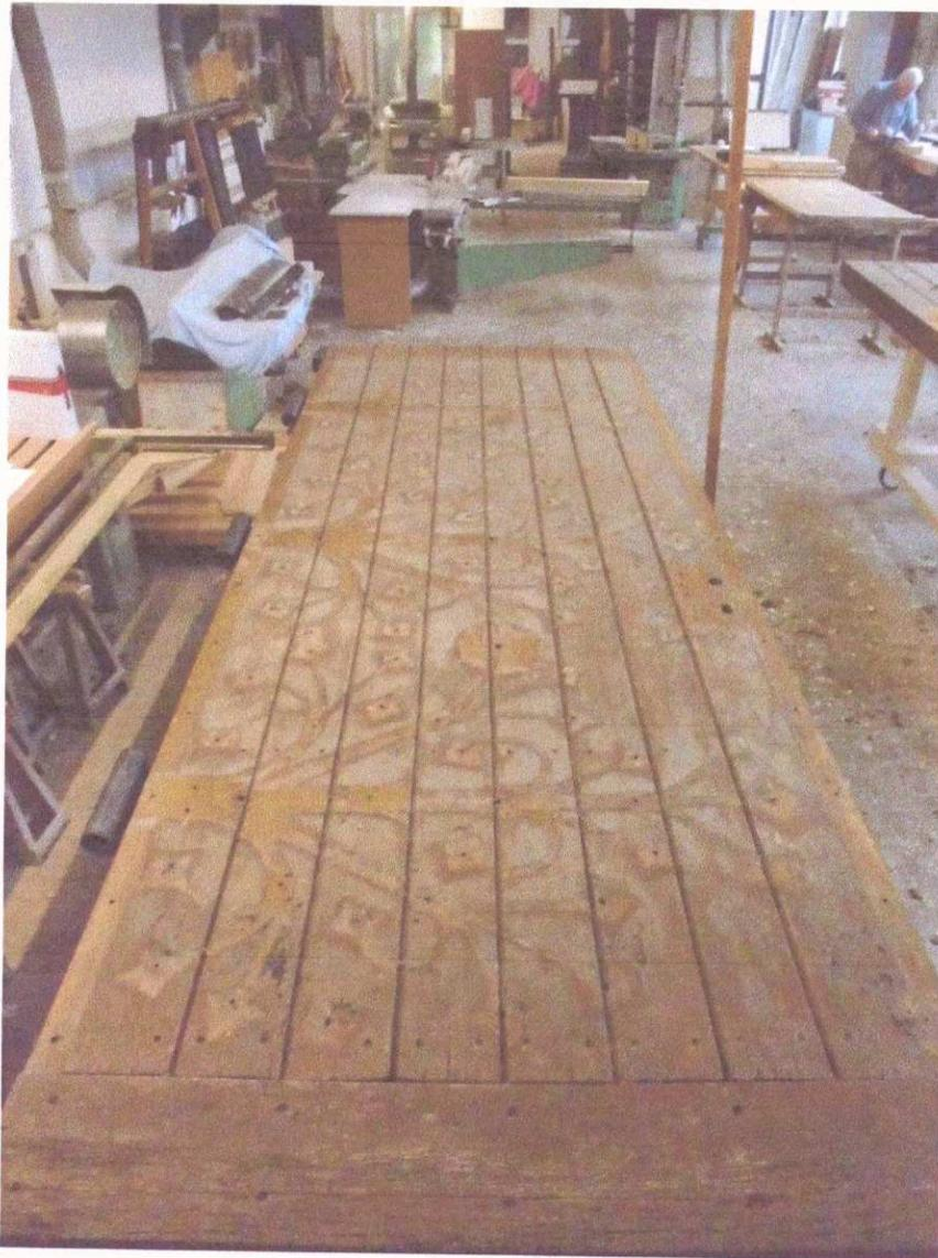
Abb. 26: Linker Türflügel nach Abnahme der Beschläge
