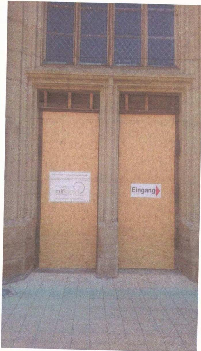
Abb. 25: Blendrahmen mit Verschluss nach Ausbau der Türflügel
