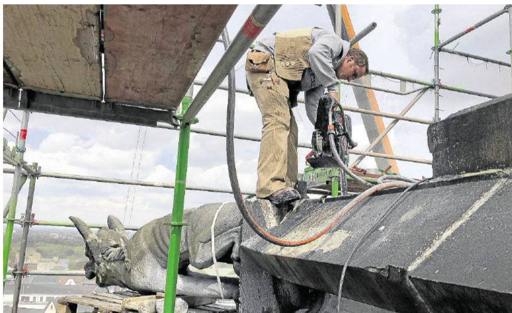
Vor allem mit einer wassergekühlten Spezialsäge trennten die Steinmetze den Wasserspeier von seinem Sockel. Das Baugerüst war zuvor schon umgebaut worden, um den Höllenhund notfalls abzufangen. FOTO RAULF
