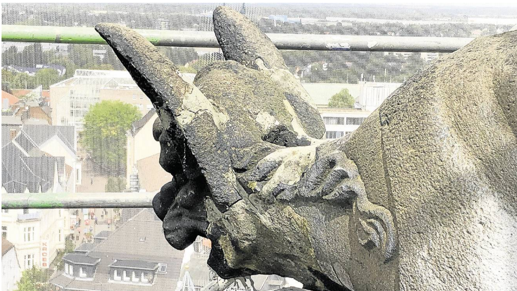
Nach mehrstündigen Arbeiten hatten die Steinmetze den nordwestlichen Wasserspeier vom Turm der Stadtkirche gelöst. Ein zweiter Höllenhund folgte wenig später. FOTO RAULF
