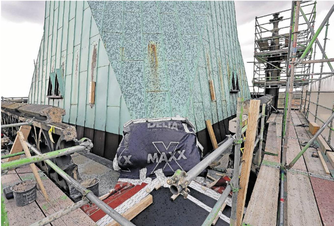
Die inzwischen abgebaute Brüstung am Turm soll künftig 35 Meter höher sein. Das ist nötig, um dahinter ein Gefälle einzurichten. Im Rahmen der Sanierung will die Bauleitung eine funktionierende Entwässerung einbauen.
