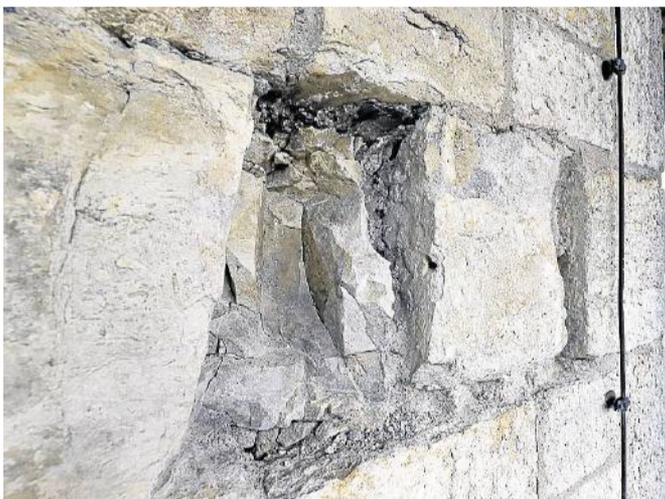
Im Inneren der Wände arbeitet das Wasser: Seit Jahrzehnten sickert Feuchtigkeit durch das Gemäuer.
