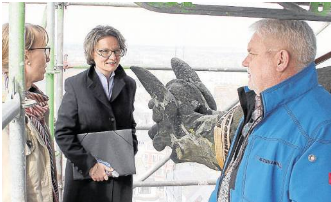
Ina Scharrenbach (M.), NRW-Ministerin für Heimat, Kommunales, Bau und Gleichstellung, ließ sich vor Ort von den Architekten Gerti Volkery und Eberhard Tiemann die Schäden an der Stadtkirche zeigen.
