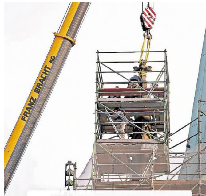
Es ist eine Arbeit in luftiger Höhe: Die Spitze der Fiale dürfte etwa 47 Meter über dem Kirchplatz stehen. Das erste Bauteil, die Blüte an der Spitze der Fiale, erscheint im Vergleich zu dem riesigen Kran winzig. Die Blüte wird als Erstes abgenommen und landet sicher auf dem Kirchplatz.
