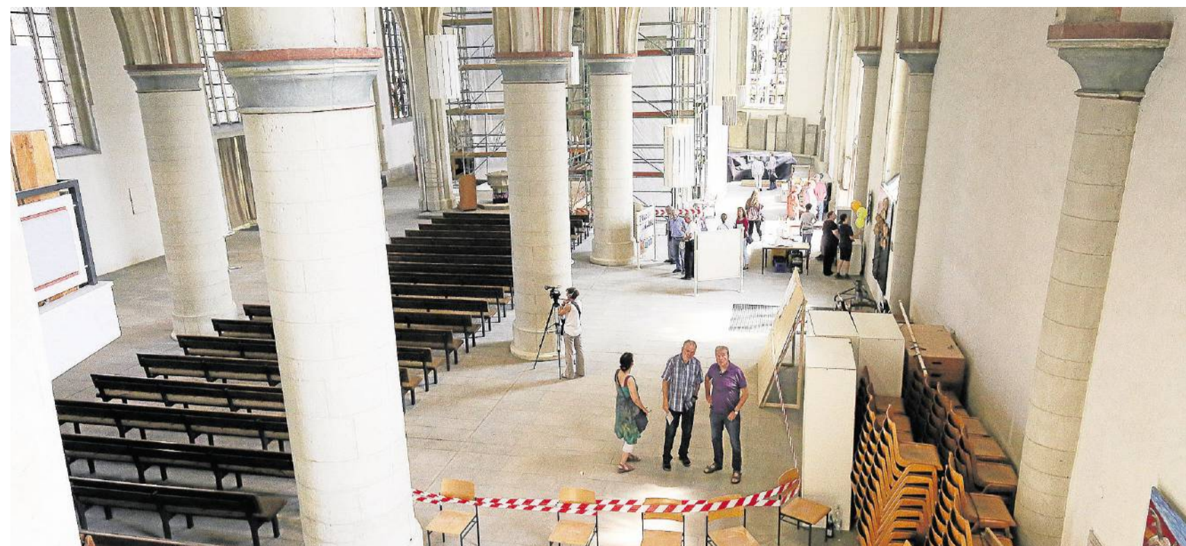
Das Innere der Stadtkirche war zum ersten Mal seit dem Sturmschaden im Januar für die Öffentlichkeit zugänglich. Viele Menschen ließen sich über die Sanierungsarbeiten informieren. FOTO: DRAWE
