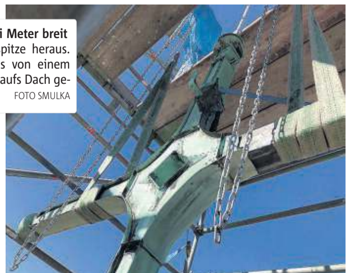
Ein Blick in den „Kaiserstiel“, der den stählernen Kern des Kreuzes mit der hölzernen Tragekonstruktion des Daches verbindet. Letztlich ist es ein aufgebohrter Baumstamm, den Pira nun neu mit einem Metallring verstärkt hat. Anderthalb Meter tief steckt das Kreuz mit seinem Dorn darin. FOTO SMULKA
