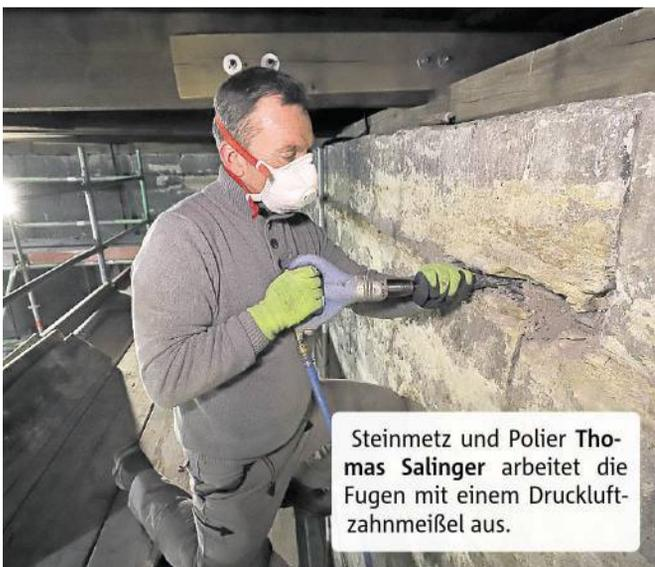
Steinmetz und Polier Thomas Salinger arbeitet die Fugen mit einem Druckluftzahnmeißel aus.
