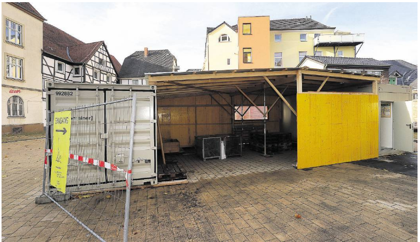
So sieht die Bauhütte von der Rückseite aus. Zwischen zwei Containern wurden hölzerne Wände und ein Dach errichtet. Vor Wind und Wetter geschützt werden Steinmetze darin Einzelteile vom Kirchturm restaurieren. FOTO DRAWE
