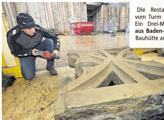
An dieser Stelle haben Wasser und Frost den Stein aufgesprengt. Solche Schadstellen werden nicht wieder aufgefüllt, nur glatt ausgeschliffen. FOTO RAULF
