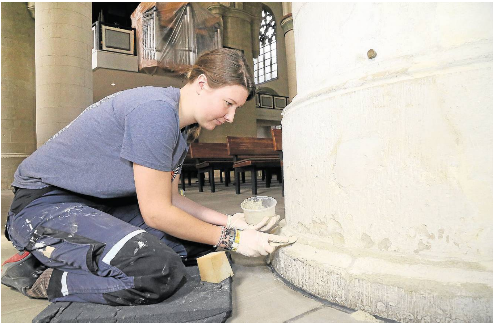
Lena Weitzenbürger trägt Mörtel an einer der sechs Rundsäulen im Mittelschiff der Stadtkirche auf. Sie absolviert ein Freiwilliges Soziales Jahr bei einem Restaurierungsbetrieb, der derzeit in Unnas ältestem Gebäude am Werk ist. Weitzenbürger
