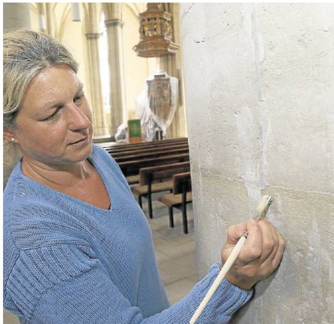
Der Pinsel ist eines der wichtigsten Werkzeuge für Jana Nowak. Die Diplom-Restauratorin trägt Farbe auf, die sie von Hand gemischt hat. Die alte Säule soll wieder einheitlich wirken.
