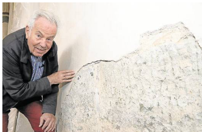
Hans-Peter Wigger begutachtet ein freigelegtes Stück der Außenwand. Auch darin erzeugen Wasser und Salze Druck, der den Putz abplatzen lässt. Die Erhaltung der Mauern ist eine Daueraufgabe: Dass Feuchtigkeit aufsteigt, wird immer so bleiben.
