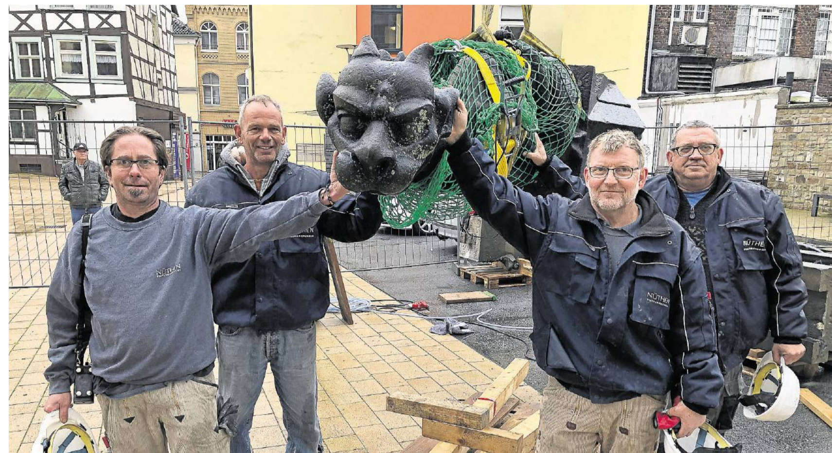
Einen der „Höllenhunde“ hatten die Arbeiter der Fachfirma Nüthen ausgebaut, um sich ein Bild vom Zustand und der Bauart der zuvor nicht sichtbaren Verankerung im Turm zu verschaffen. Wichtigstes Ergebnis der bisherigen Untersuchungen: Rein technisch ist die Turmbalustrade zu retten. FOTO SMULKA
