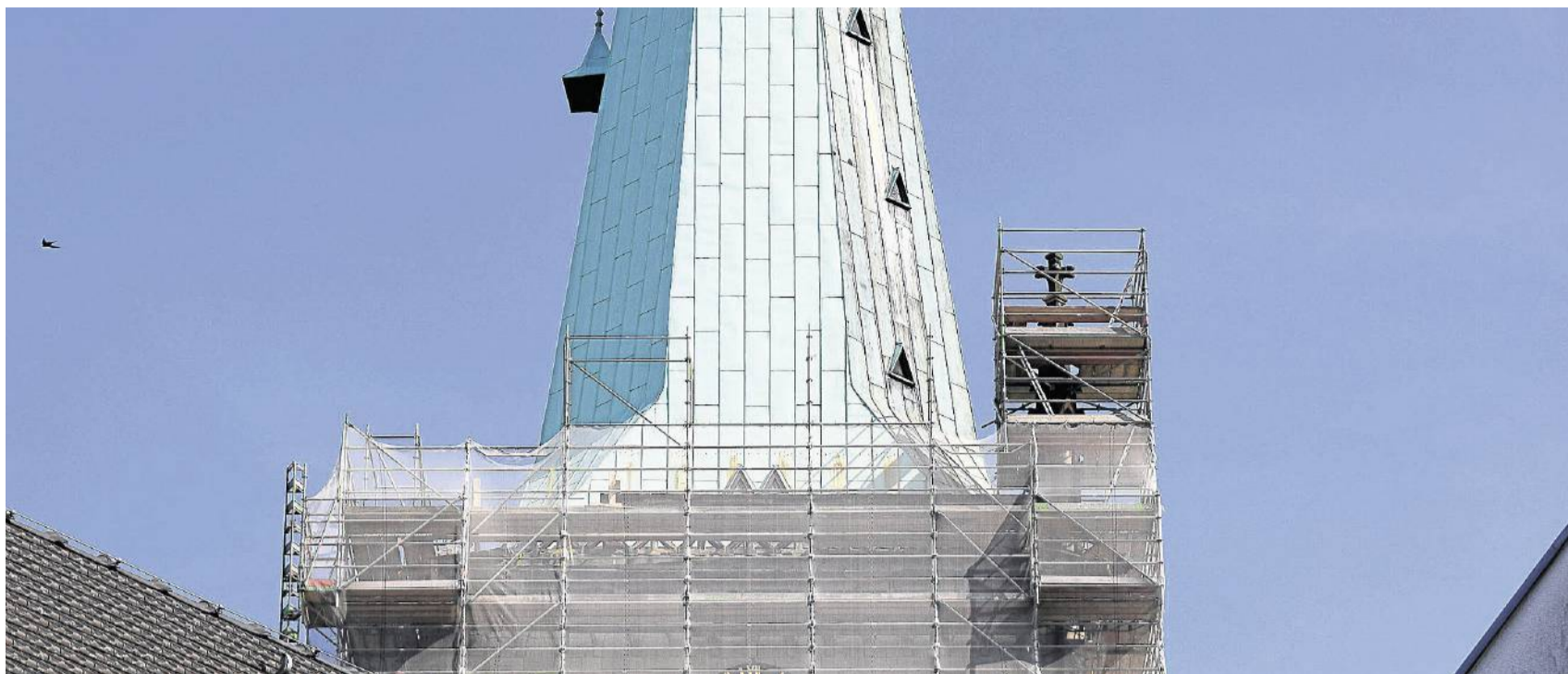
Die aktuelle Situation lässt erahnen, wie die Stadtkirche Unna ohne Fialen und Höllenhunde aussieht. An der südwestlichen Ecke (links) ist beides bereits abgebaut, an der südöstlichen Seite steht die Demontage noch bevor.
