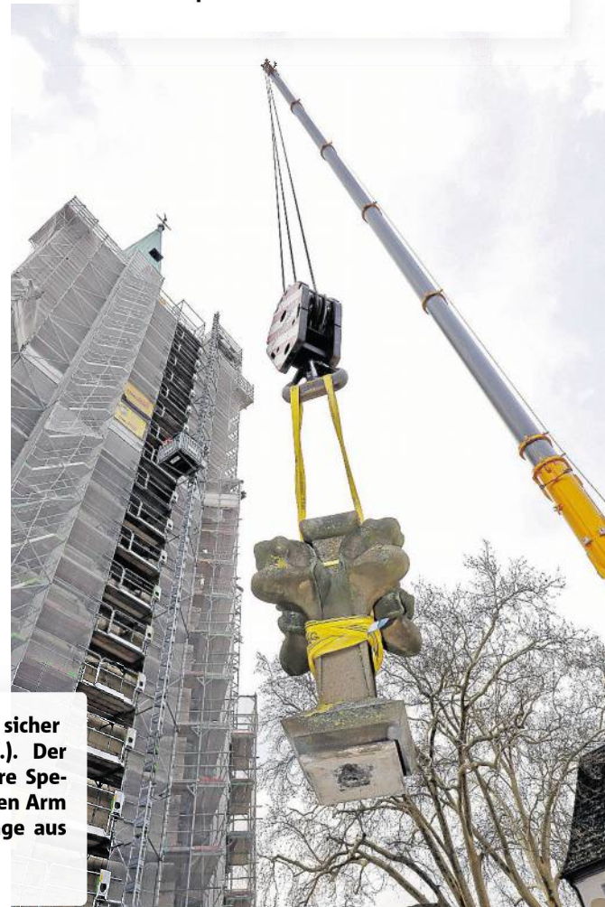
Es ist eine Arbeit in luftiger Höhe: Die Spitze der Fiale dürfte etwa 47 Meter über dem Kirchplatz stehen. Das erste Bauteil, die Blüte an der Spitze der Fiale, erscheint im Vergleich zu dem riesigen Kran winzig. Die Blüte wird als Erstes abgenommen und landet sicher auf dem Kirchplatz.
