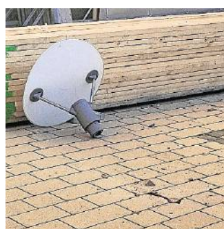
Durch den Absturz eines Eisenträgers wurde eine Laterne auf dem Kirchplatz beschädigt.
