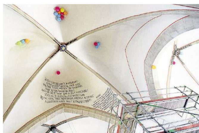
Eine der Inschriften am Deckengewölbe erinnert an den Umsturz des Turms im Jahr 1660. Daneben hängen nun bunte Luftballons als Zeichen der Hoffnung. FOTO: PÄHLER
