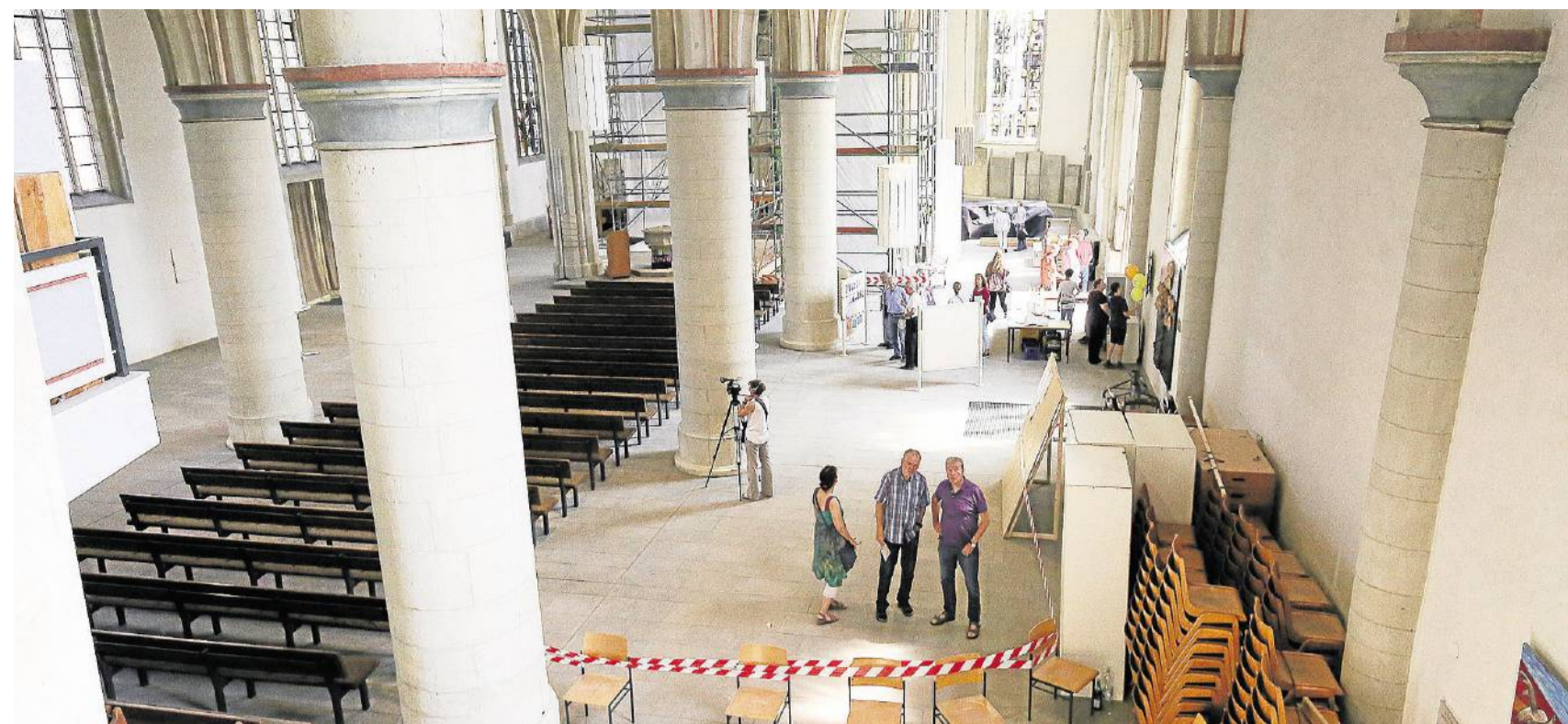
Das Innere der Stadtkirche war zum ersten Mal seit dem Sturmschaden im Januar für die Öffentlichkeit zugänglich. Viele Menschen ließen sich über die Sanierungsarbeiten informieren. FOTO: DRAWE
