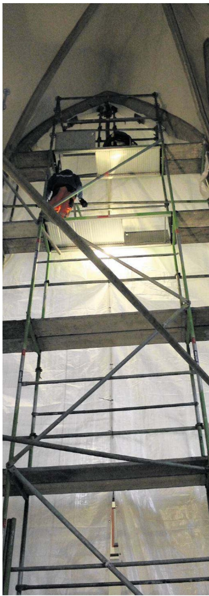
Komplett verdeckt: Das Gewölbe ist im Innenraum nun mit einer Staubschutzwand gesichert. FOTO: KIRCHENKREIS
