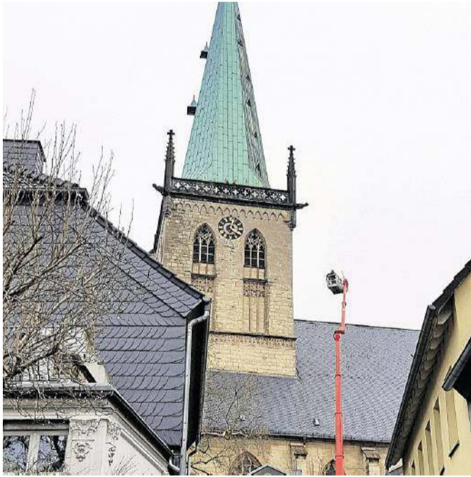
Ende vergangener Woche waren Experten mit einem Hubwagen vor Ort, um die Fassade zu untersuchen. FOTO: GEMÜND
