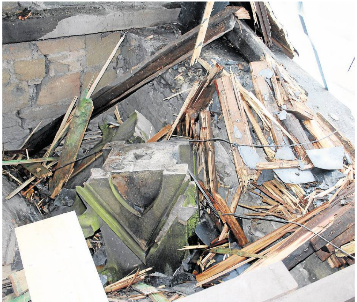
Die Schäden am Kreuzgewölbe über der Orgelbühne sind so groß, dass der Aufenthalt in der Stadtkirche gefährlich ist. Sie bleibt für mehrere Wochen gesperrt. Das rechte Foto zeigt den Teil des Äquials, der auf das Dach der Kirche gestürzt ist und für die Risse und Versätze an der Decke gesorgt hat.
