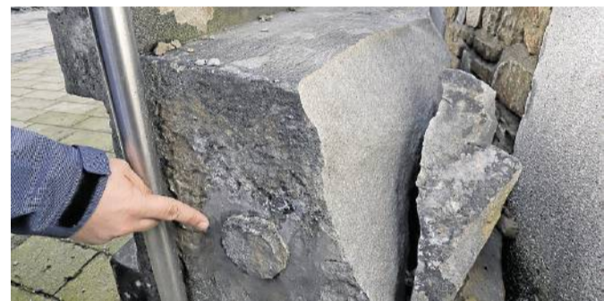
Mit solchen Zapfen sind die jeweils drei Teile der Zierelemente miteinander verbunden.
